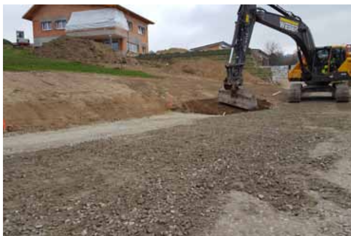
Straßenbau im neuen Wohngebiet Hammermühle
