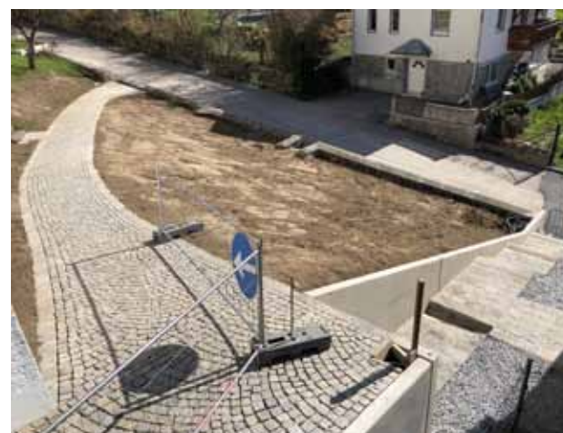
Bild unten: Aufgang und neue Stiege
