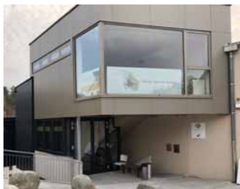
Erweiterung im Textilien Zentrum Haslach
